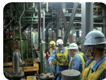
環境重点設備点検
